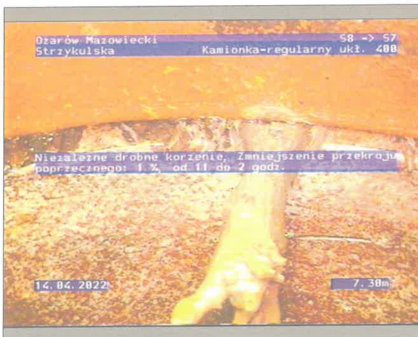
Zdjęcie: 1_1_3_14042022_094520_A.JPG 7,3m, Niezależne drobne korzenie, Zmniejszenie przekroju poprzecznego: 1 %, od 11 do 2 godz.
